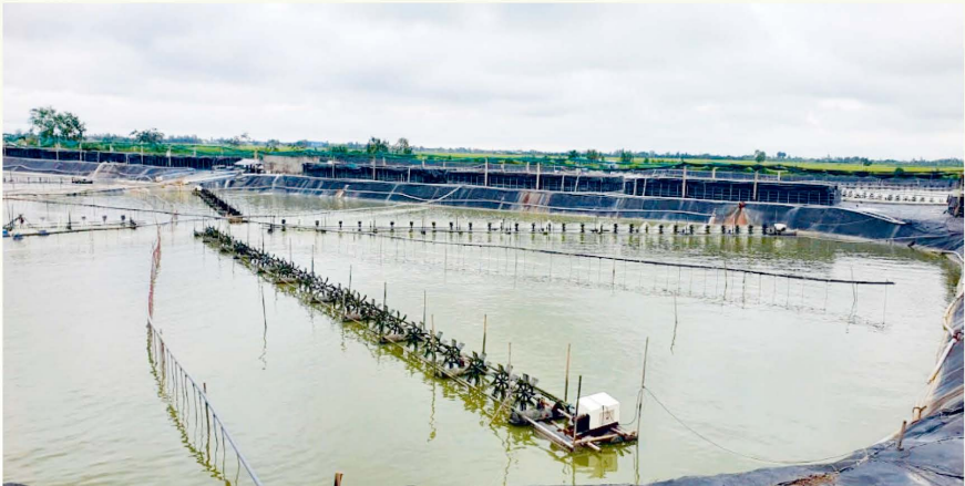
Hình 8: Hệ thống quạt nước, sục khí đáy ao trong ao nuôi thâm canh
