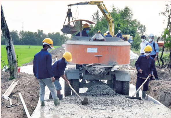
Hoạt động nâng cấp đường đê bao tại xã Định An, huyện Gò Quao
